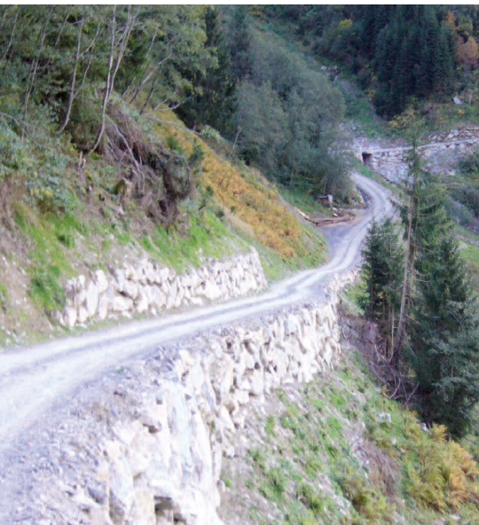
Abb. 2: Neue Linienführung mit aufwändigen Böschungssicherungen.
